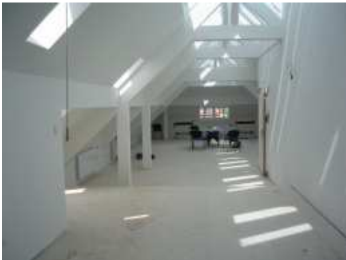
Blick vom Eingang zum Eventbereich
